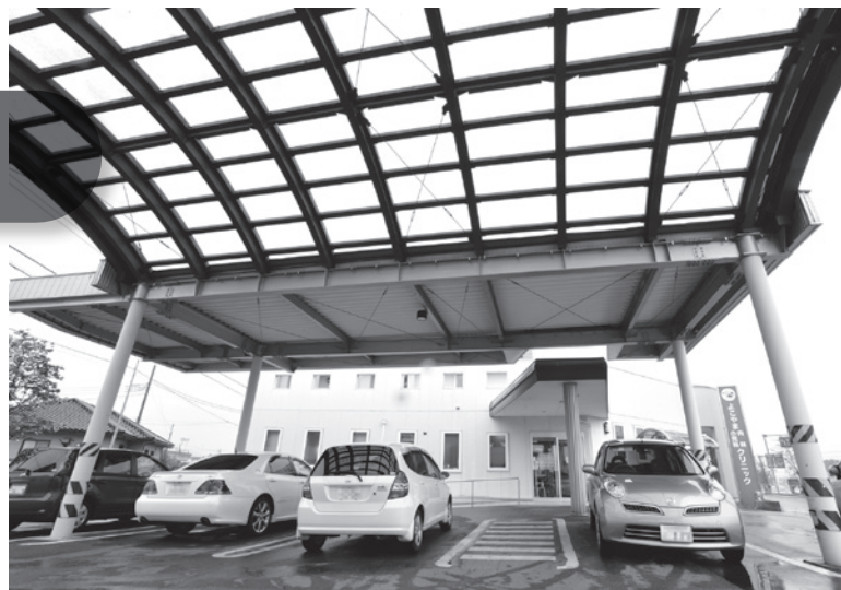
駐車場全体を覆う屋根。雨の日でも濡れずに診療所に入ることができる
